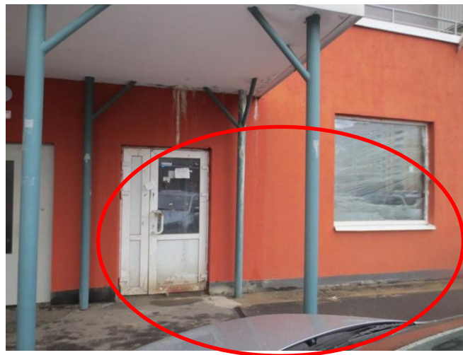
Фотография 10. Фасад здания, где расположено оцениваемое помещение, вход со двора
