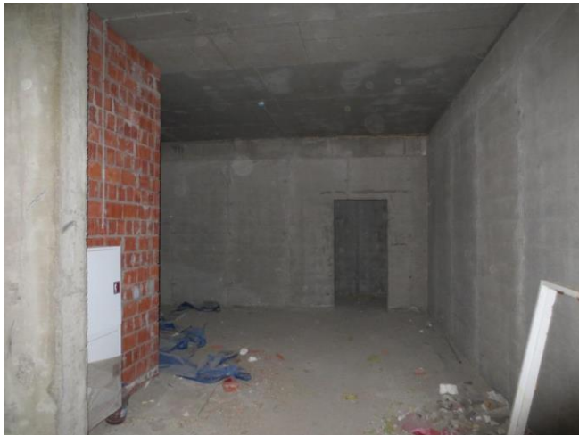
Фотография 37. Внутренняя отделка помещения
