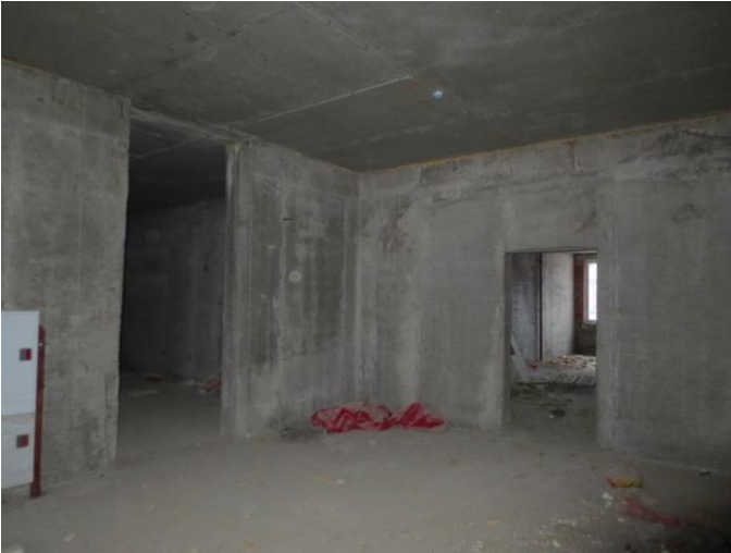
Фотография 35. Внутренняя отделка помещения
