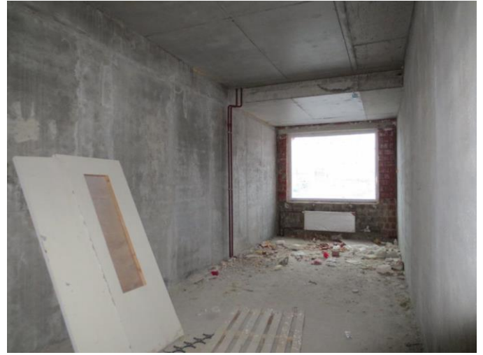
Фотография 36. Внутренняя отделка помещения
