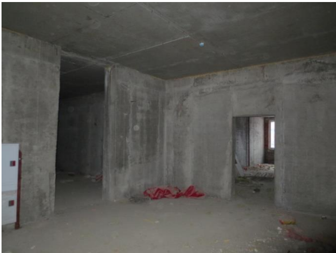
Фотография 39. Внутренняя отделка помещения
