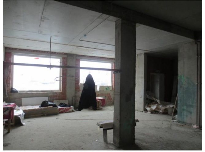
Фотография 16. Внутренняя отделка помещения
