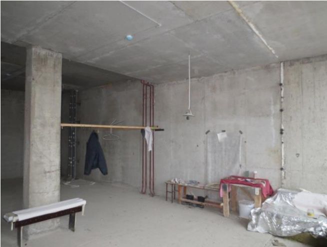
Фотография 15. Внутренняя отделка помещения
