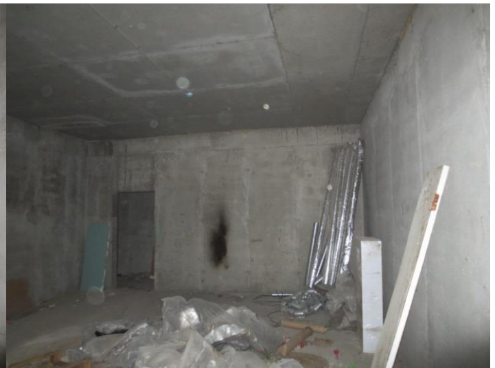
Фотография 20. Внутренняя отделка помещения
