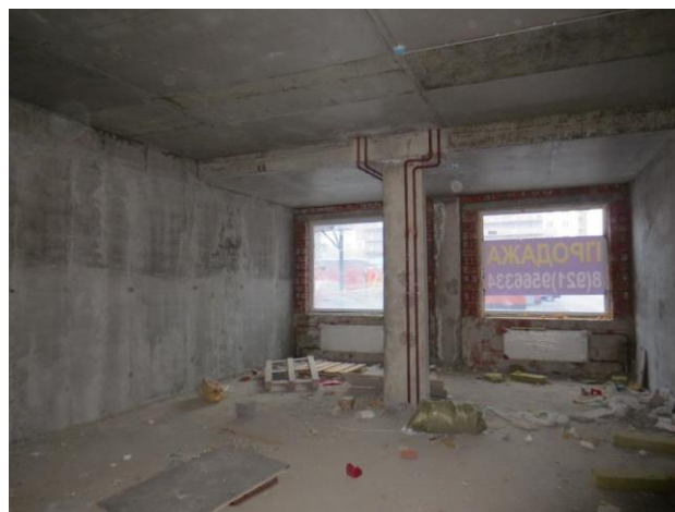
Фотография 32. Внутренняя отделка помещения
