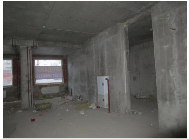
Фотография 38. Внутренняя отделка помещения
