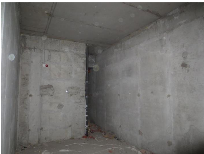
Фотография 33. Внутренняя отделка помещения
