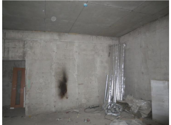
Фотография 22. Внутренняя отделка помещения
