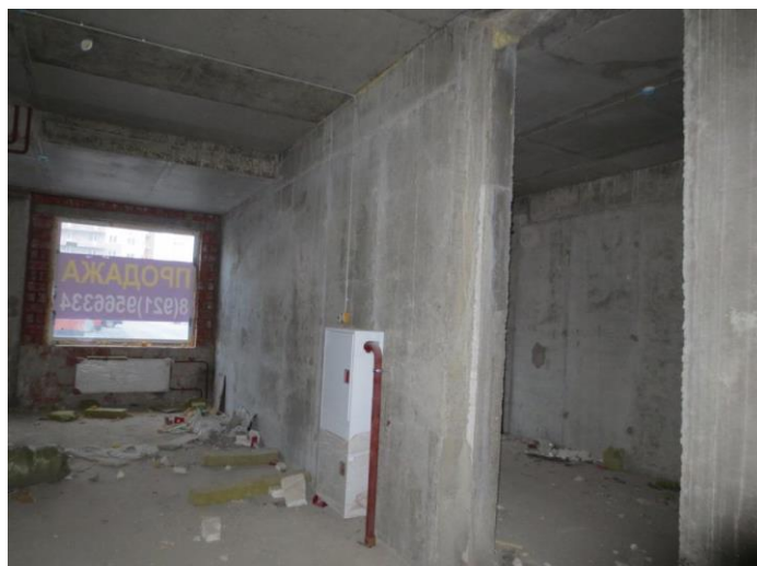
Фотография 34. Внутренняя отделка помещения
