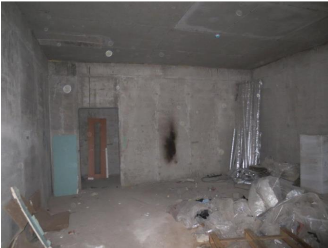
Фотография 17. Внутренняя отделка помещения
