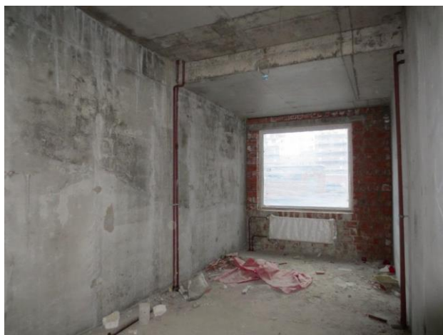
Фотография 31. Внутренняя отделка помещения
