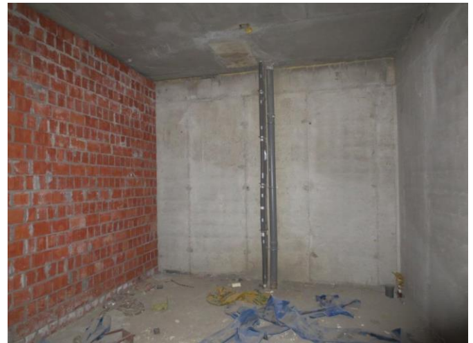
Фотография 40. Внутренняя отделка помещения
