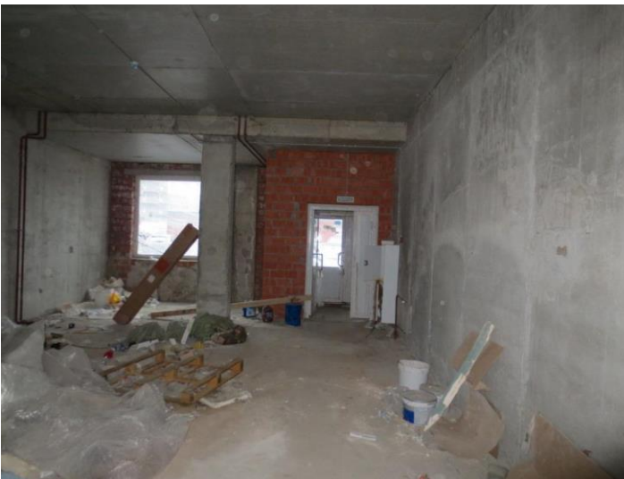
Фотография 19. Внутренняя отделка помещения
