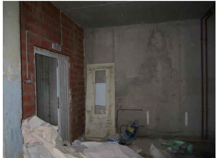
Фотография 18. Внутренняя отделка помещения
