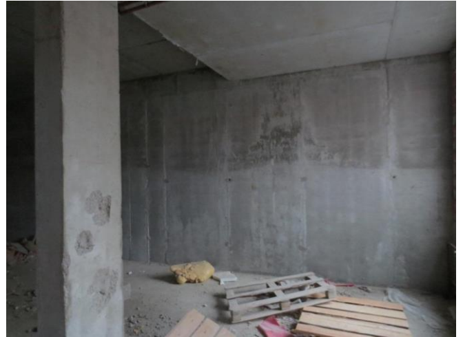
Фотография 42. Внутренняя отделка помещения
