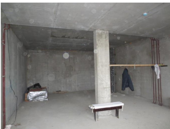
Фотография 13. Внутренняя отделка помещения
