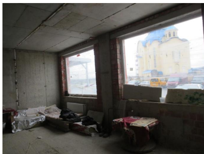
Фотография 14. Внутренняя отделка помещения
