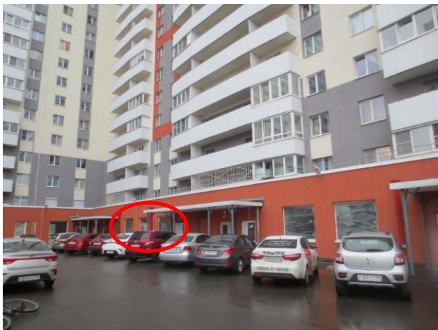
Фотография 29. Фасад здания, где расположено оцениваемое помещение, 3 окна во двор
